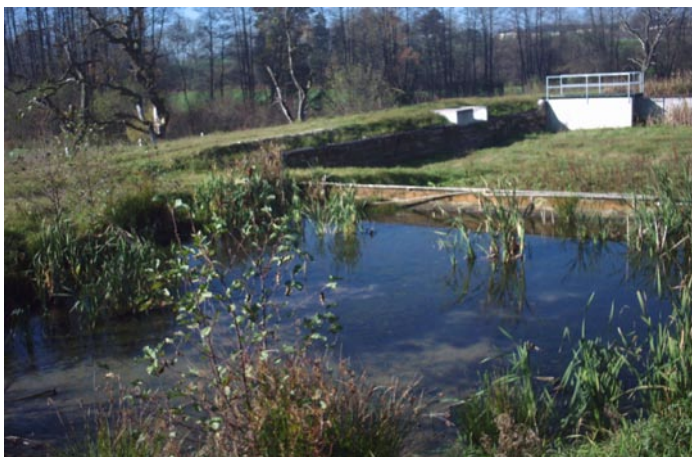
ökologisch gestaltetes Retentionsbecken
