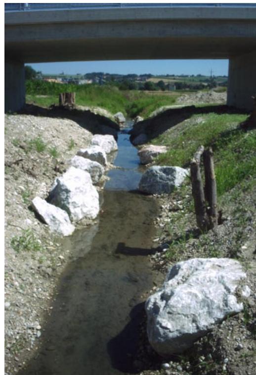
Aubach nach dem Brückenbau (noch ohne Bepflanzung)
