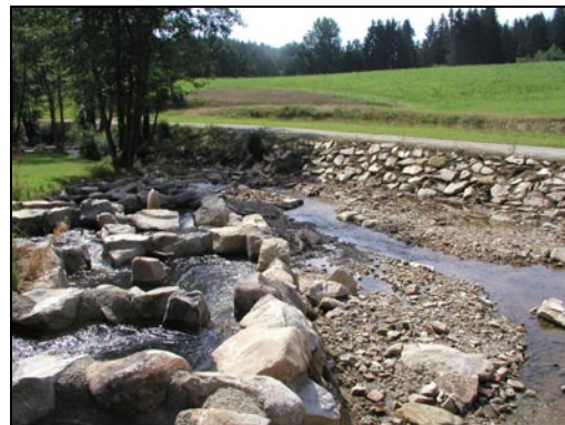
Fertig gestellte Organismenaufstiegshilfe (150 l/s)
