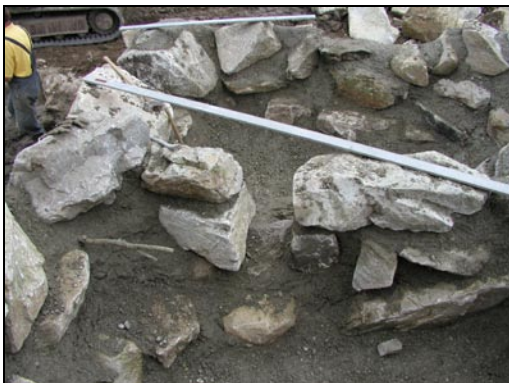
Herstellung des Tümpelpasses
