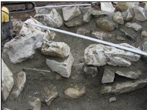
Herstellung des Tümpelpasses
