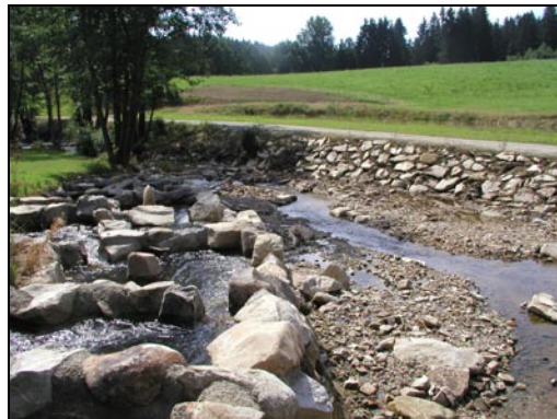
Fertig gestellte Organismenaufstiegshilfe (150 l/s)
